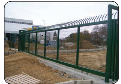
Tek Yapı İnşaat A.Ş. BSH Çerçekköy Fabrikası
