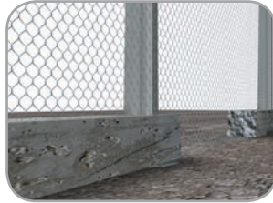
Bağımsız Betonlama ve Hatıl
