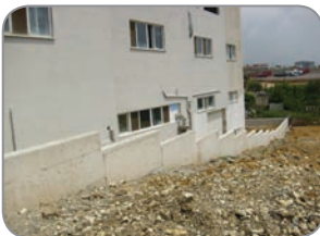
Garanti Yemek Gebze Fabrikası Betonarme Duvar Uygulaması
