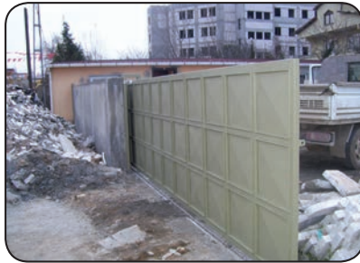
Mermeras A.Ş. Kurtköy Fabrikası
