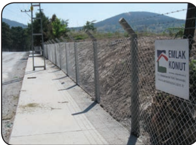
Emlak Konut A.Ş. Alemdağ Şantiyesi
