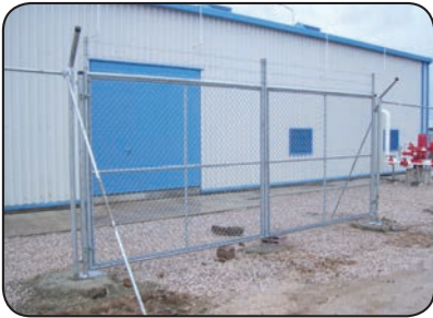
Alarko A.Ş. Kırklareli Doğalgaz Çevrim Santrali
