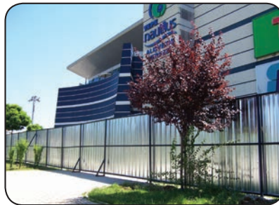
Anadoluray/Ayrılıkçeşme Şaftı/Kadıköy Yapı Mrk. &Doğuş&Yüksel&Yeniğün Ort. Girişimi
