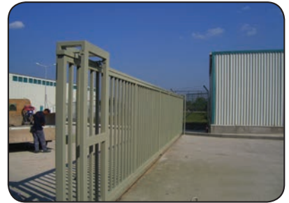
Tek Yapı İnşaat A.Ş. Fritolay İzmit Fabrikası
