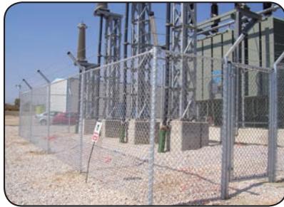
Alarko A.Ş. Kırklareli Doğalgaz Çevrim Santrali
