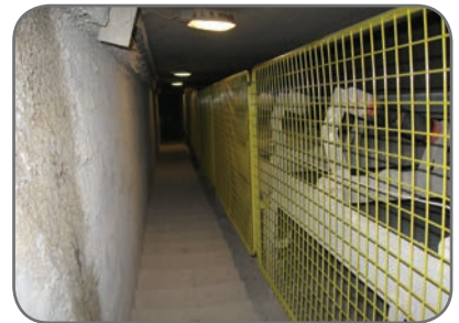
Bolu Çimento Fabrikası Konveyör Koruma Çiti
