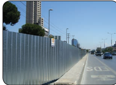
Avrasya Metro Grubu/Kozyatağı Şaftı Astaldi&Mak-Yol & Gülermak Ortak Girişimi Kadıköy-Kartal Metrosu İkmal İnşaatı
