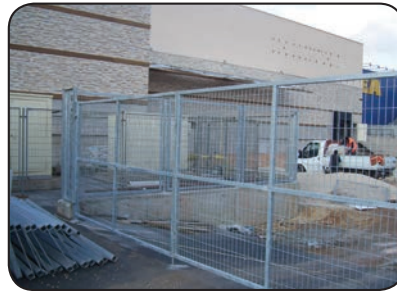
Maya İnşaat A.Ş. Bursa IKEA AVM İnşaatı
