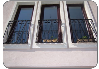
Ferforje Korkuluk Uygulaması/Ataşehir
