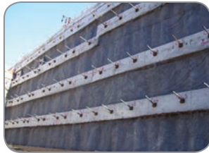
MT İnşaat/Anel İş Merkezi/Ümraniye Fore Kazık Yüzey Uygulaması
