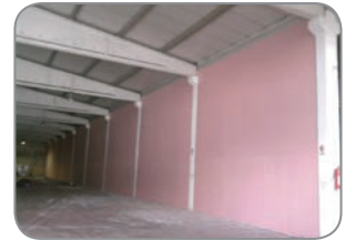
Yeni Antalya Transport Yangın Duvarı Uygulaması/Hadımköy
