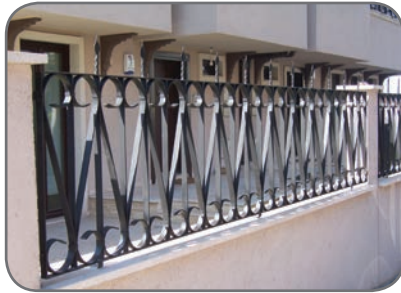
Ferforje Çit Uygulaması/Ataşehir
