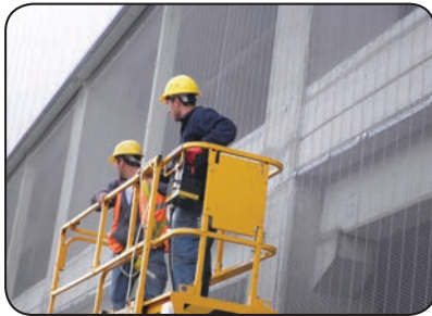
Mayser İnşaat A.Ş. Ankara IKEA Alışveriş Merkezi
