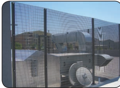
Kale Metal A.Ş. / Tuzla Fabrikası
