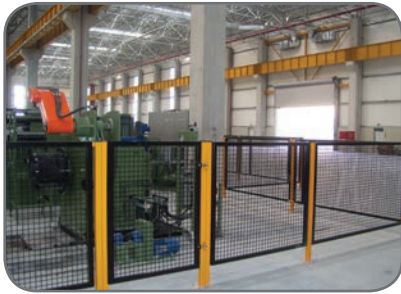
Suma Ltd. Şti. Thyssen Gebze Fabrikası
