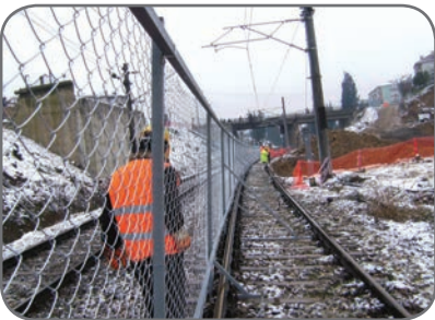
Doğuş İnşaat A.Ş. Marmaray/Gebze Tren İst. Ray Koruma Çiti
