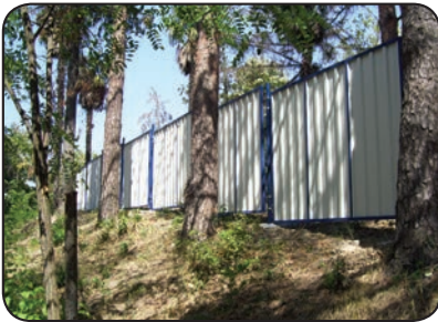
Limak İnşaat A.Ş. Yalova/Termal Otel İnşaatı
