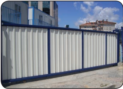
Limak İnşaat A.Ş. Kavacık Otel İnşaatı
