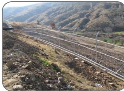
Makro İnşaat A.Ş. Bingöl/Yayla TOKİ Karakol İnşaatı
