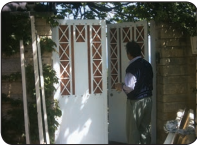
Tezcan Holding Kapı Uygulaması/Büyükada
