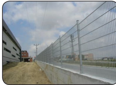
İdeal Plastik Ltd. Şti. Hadımköy Fabrikası
