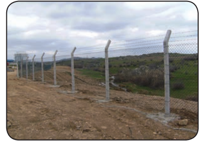
Alarko A.Ş. Kırklareli Doğalgaz Çevrim Sant.
