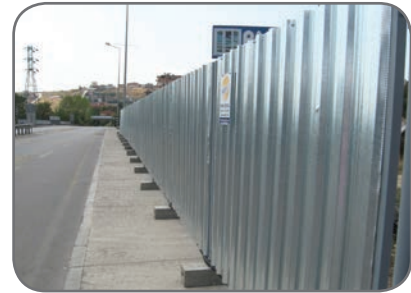
Doğuş İnşaat A.Ş. Marmaray Projesi-Gebze Tren İstasyonu
