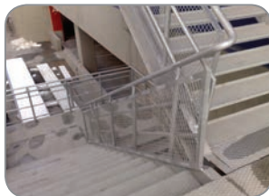
Maya İnşaat A.Ş./IKEA Bayrampaşa Merdiven Korkuluğu Uygulaması
